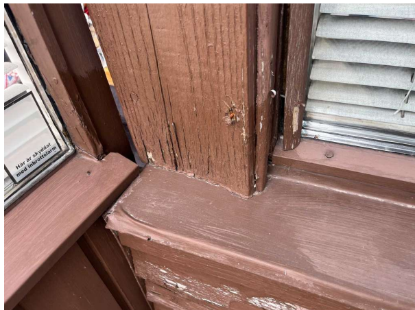
Bild 6: -Fönster/Dörrar, Fönster och dörrar med tillhörande foder är i behov av underhåll/renovering. Se Riskanalys.
