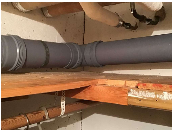
Bild 17: -Källarplan, Sprickbildning noteras på grundmur och i väggskarv vilket kan vara tecken på sättningar. Se Grundläggning.
