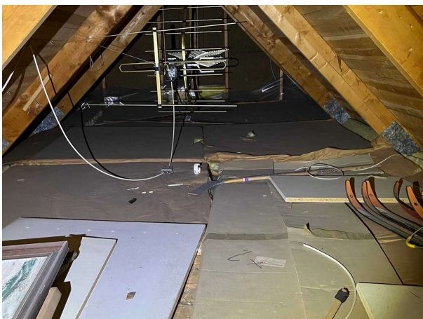
Bild 5: Utvändigt, Vind, Nockvinden samt den stora stickvinden är ej besiktningsbara i sin helhet på grund av att det sakn...
