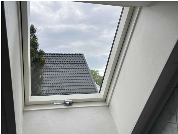
Bild 2: - Utvändigt, Fönster/Dörrar, Fönster utgörs av isolerglaskassetter. Även dörrar har fönster av denna typ. Takfönster finns. Se...
