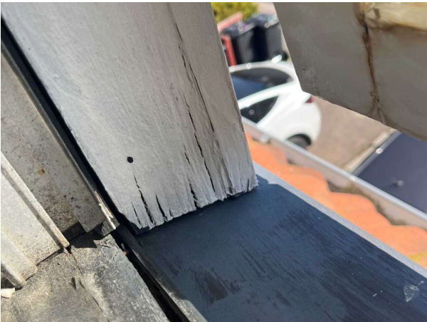
Bild 27: - Invändigt, Plan 1, Fuktrosor/missfärgningar noteras på fönster. Se notering Vardagsrum. Det noteras även rötskador p...
