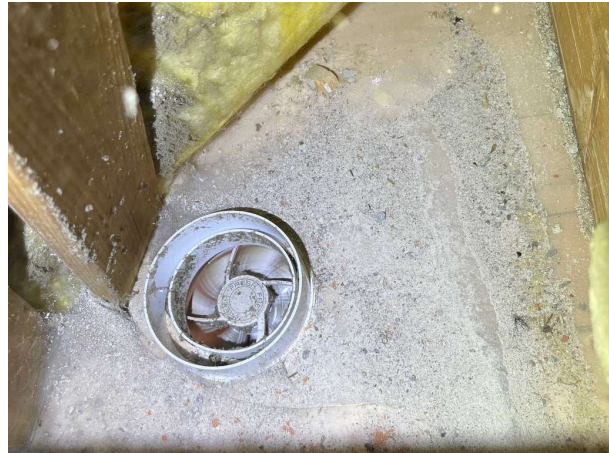
Bild 8: - Utvändigt, Vind, Ventilationskanaler avslutas på vinden. Se Riskanalys.
