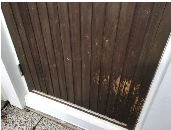
Bild 4: Utvändigt, Fönster/Dörrar, Fönster och dörrar bedöms generellt ha normalt underhållsbehov.
