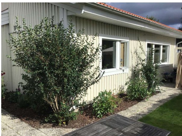
Bild 1: Utvändigt, Mark, Det förekommer närliggande planteringar. Se Riskanalys.
