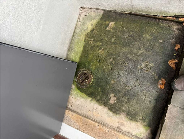
Bild 1: Utvändigt, Dränering/Dagvatten, Dagvattenbrunn noteras i nedgång till källare. Det är viktigt att dessa brunnar regelbundet rensa...
