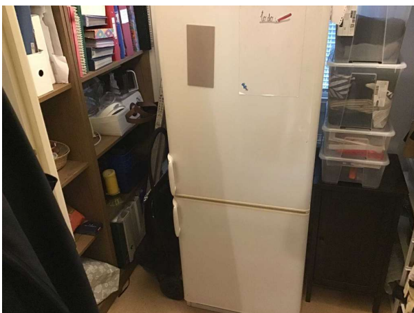
Bild 11: Entréplan, Utrymmet var vid besiktningstillfället delvis belamrat varför det ej gått att kontrollera på ett fullgott sätt. Besiktning bör ske när utrymmet tömts.
