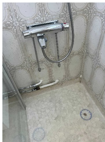
Bild 10: - Invändigt, Entréplan, Rör genomföringar noteras genom tätskikt på vägg i duschzonen. Se Riskanalys.
