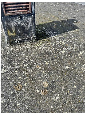
Bild 7: Utvändigt, Tak, Påväxt av mossor och lavar noteras på taket. Detta förhållande kan påverka takets tekniska livslän...
