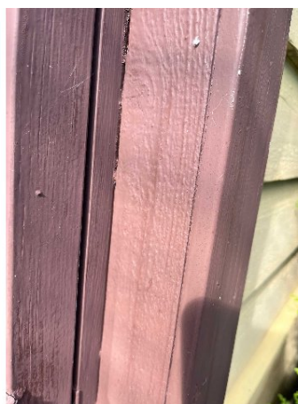
Bild 4: - Utvändigt, Fönster/Dörrar, Otäta fönster/dörromfattningar noteras i byggnaden. Se Riskanalys.
