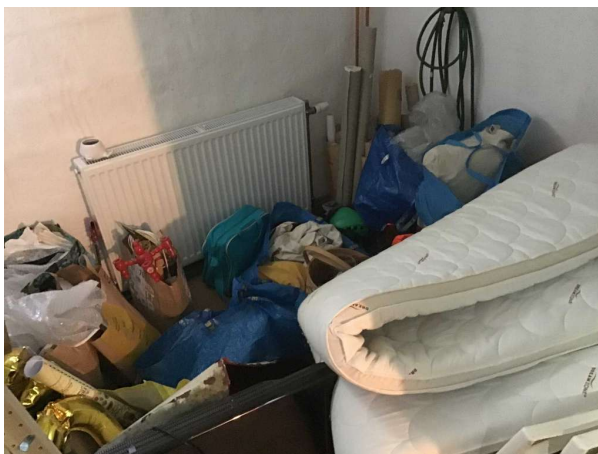
Bild 24: Invändigt, Källare, Utrymmet var vid besiktningstillfället delvis belamrat varför det ej gått att kontrollera på ett ...
