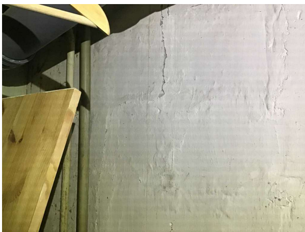
Bild 2: Utvändigt, Grundläggning, Sprickor noteras lokalt på insida grundmurar. Sprickorna bedöms i sin nuvarande form inte påverka...
