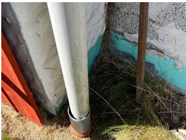
Bild 5: Utvändigt, Dränering/Dagvatten, Lövsilar saknas där stuprör möter markrör.
