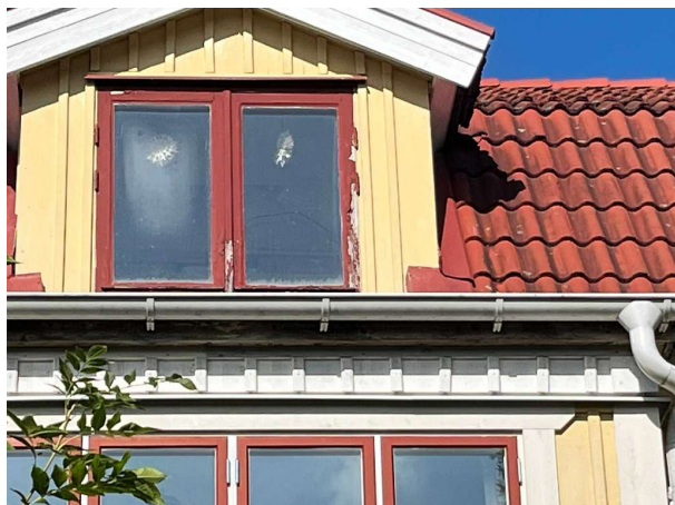
Bild 9: Utvändigt, Fönster/Dörrar, Fönster och dörrar har generellt ett underhållsbehov. Det noteras färgsläpp på några fönster samt...
