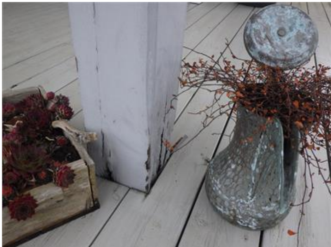
Rötskadad pelare.
