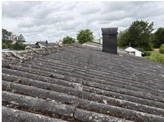
Bilden visar vy av tak som består av eternit.
