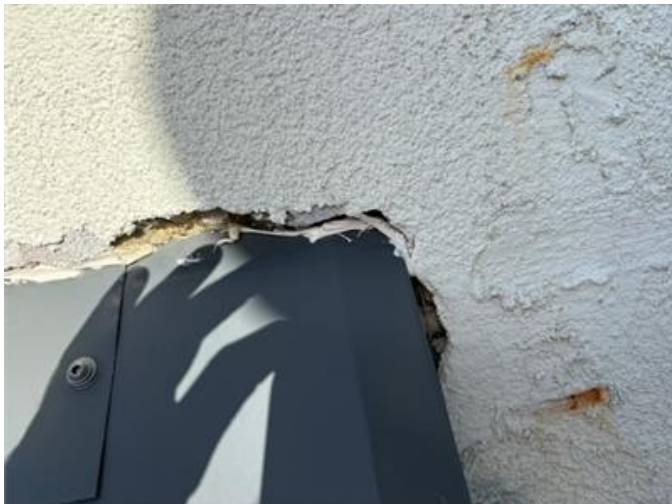
Bilden visar exempel på otätheter/brister i fasaden.
