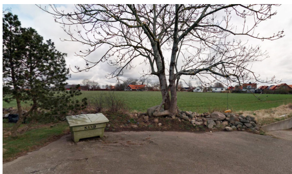
Den del av muren där en av öppningarna föreslås, för att kunna koppla ihop planområdet med Fritsa lyckeväg.
