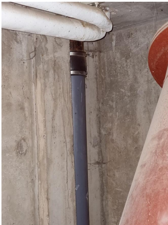
Utbytt avloppsrörs pga. läckage
