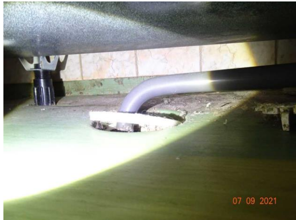
Bild 2: Gammal golvbrunn med lös klämring
