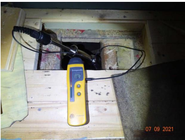
Bild 15: Fuktmätning i bjälklag bakom badrum
