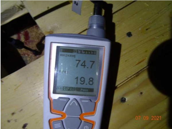
Bild 13: Relativ fuktighet strax under 75%
