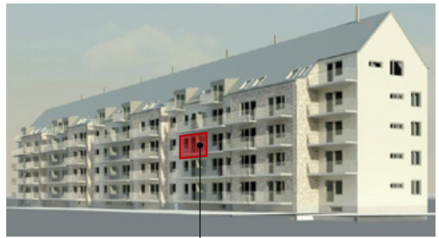
Fasad mot väster
