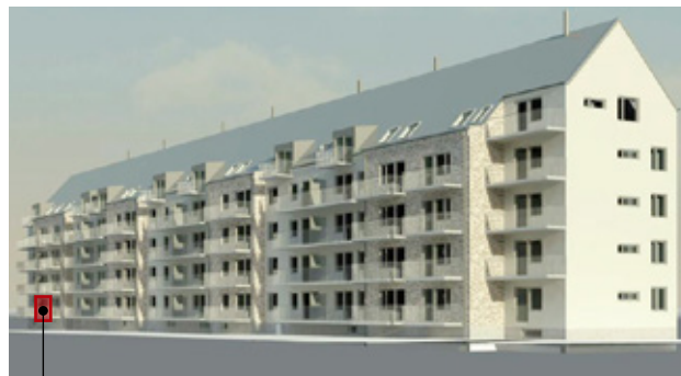
Fasad mot väster
