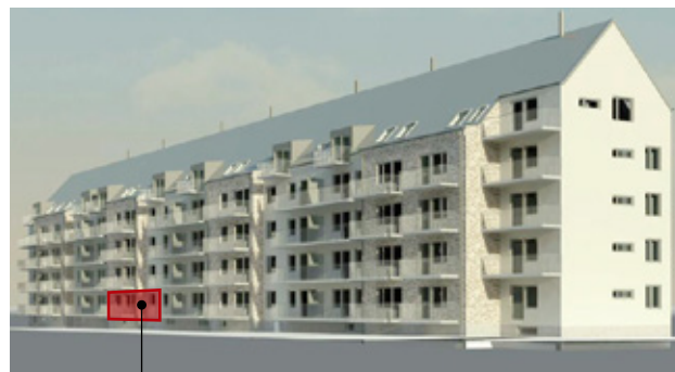
Fasad mot väster
