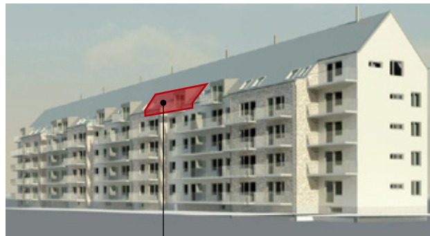
Fasad mot väster
