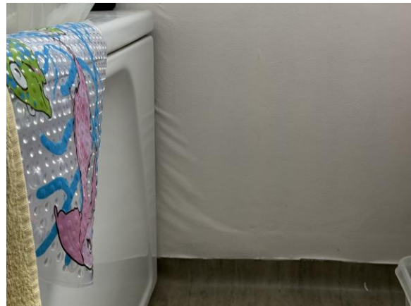
Våtrumstapet släpper från underlaget i badrum.
