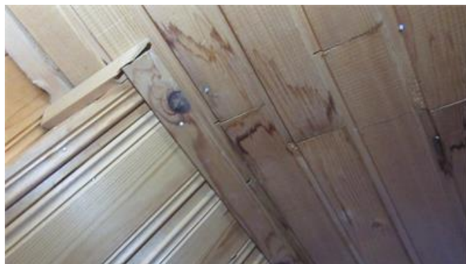
Missfärgning innertak övre plan.
