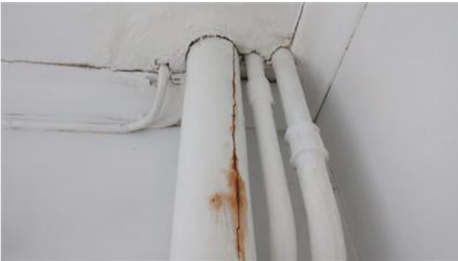
Sprucket gjutjärnsrör på övre plan.
