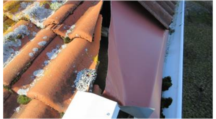
Ej färdigställt plåtarbete tak.
