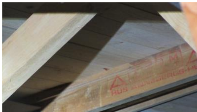
Mikrobiell påväxtnockvindens underlagstak.
