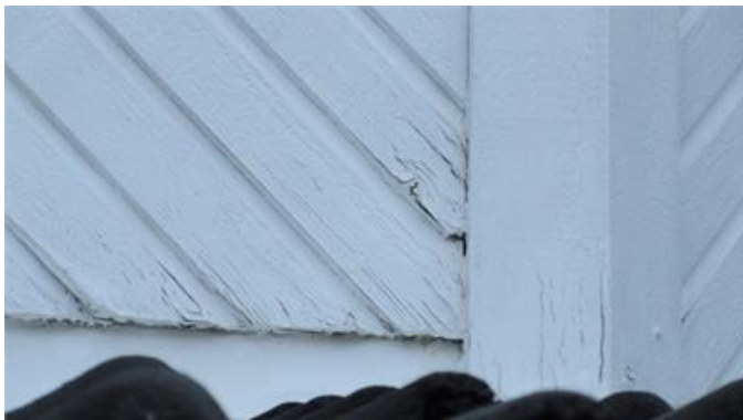
Rötskada fasadpanel.
