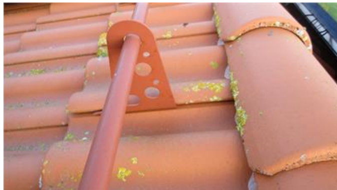
Panna ligger fel i anslutning till infästning.
