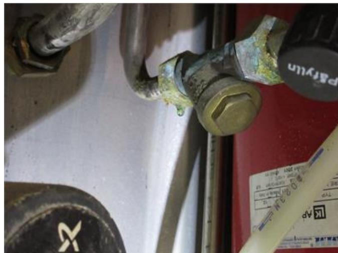
Dropläckage fjärrvärmecentral.
