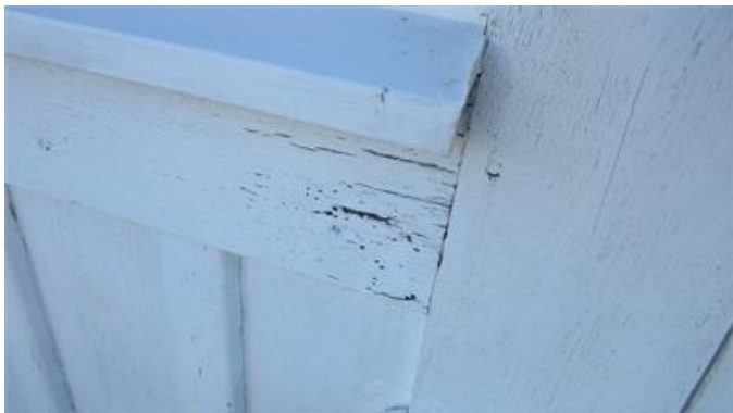
Rötskador foder.
