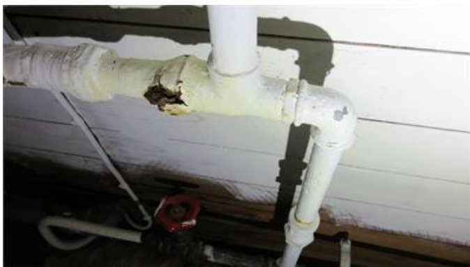
Rostangripet rör i källare.
