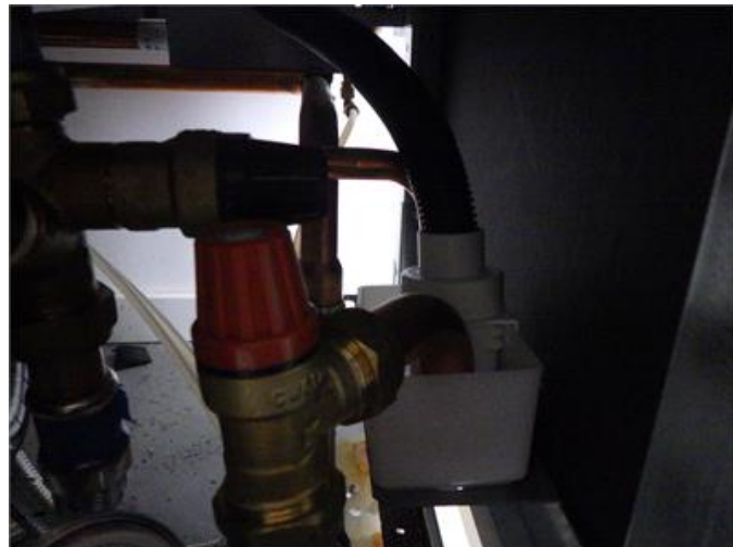
Anslutningsslang till överfyllnadsskydd av frånluftsvärmepump finns ej.
