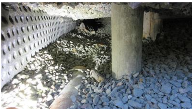
Vy under betongplatta på den tillbyggda delen.
