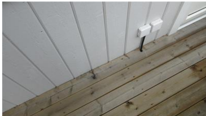
Fasadpanel nära/bakom altan.
