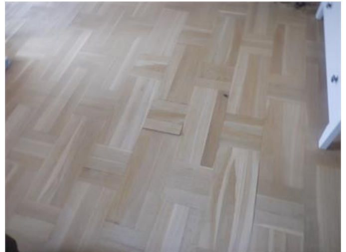
Bilden är tagen i vardagsrummet och visar laminaten på parkettgolvet som släppt från stommen
