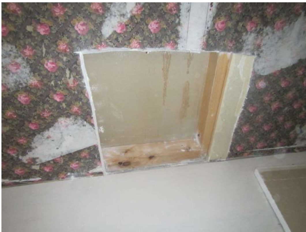
Bild 3. Provhål i innervägg mellan sovrum och vardagsrum. Syll och väggregel av obehandlat virke.
