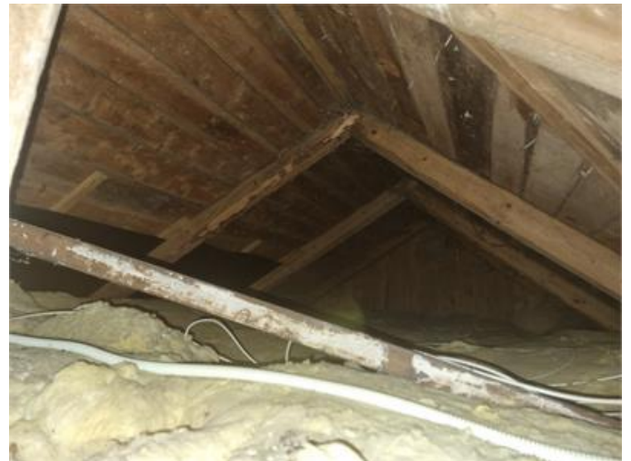
Översiktsbild, vind. Vy från luckan.
