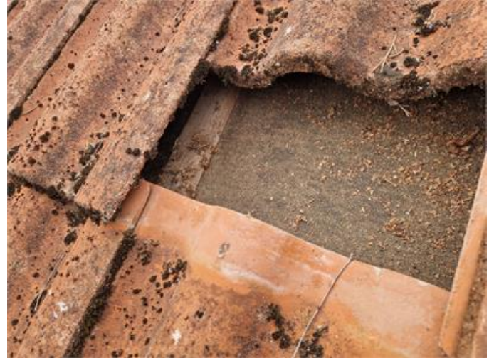
Vy på underlagstak
