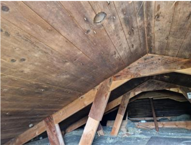
Vy på vindsutrymmet
