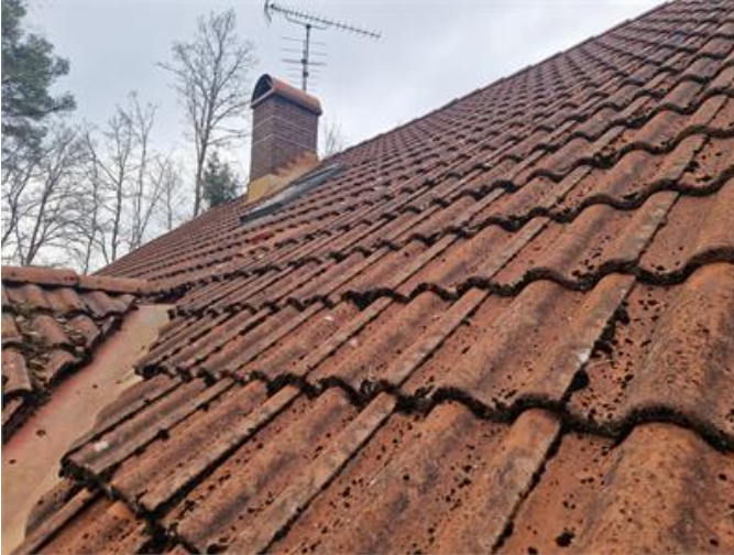
Vy på yttertak
