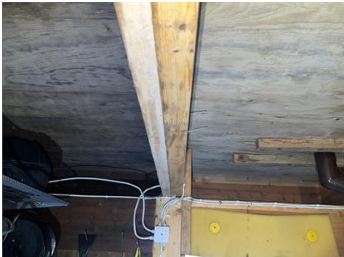
Underlagstak i Förråd
