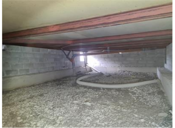
Krypgrund, översiktsbild västra delen.
