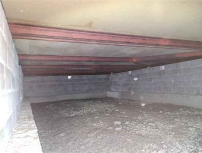
Krypgrund, översiktsbild östra delen.
