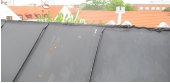
Foto 7. Nock är tätad med mjukfog.
