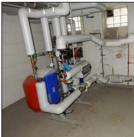
Värmeväxlare
