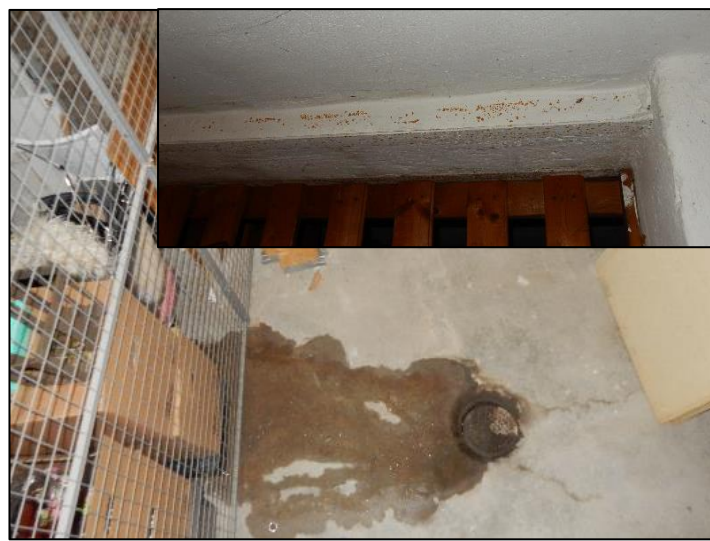
Skador i trapphusväggar/tak (översta våningen) Disponentgatan Rostangrepp balk och läckage i källare
