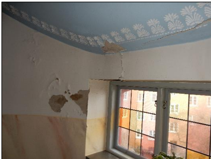
Skador i trapphusväggar/tak (översta våningen) Disponentgatan Rostangrepp balk och läckage i källare
