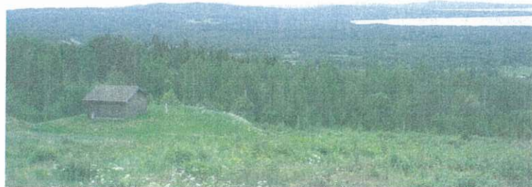
Tryckstegringsstation med vacker utsikt
