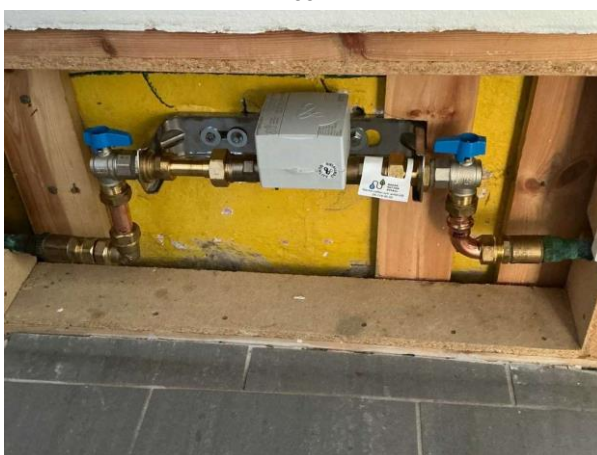
Bild 6: Invändigt, Souterrängplan, Inkommande vatten saknar tät botten
