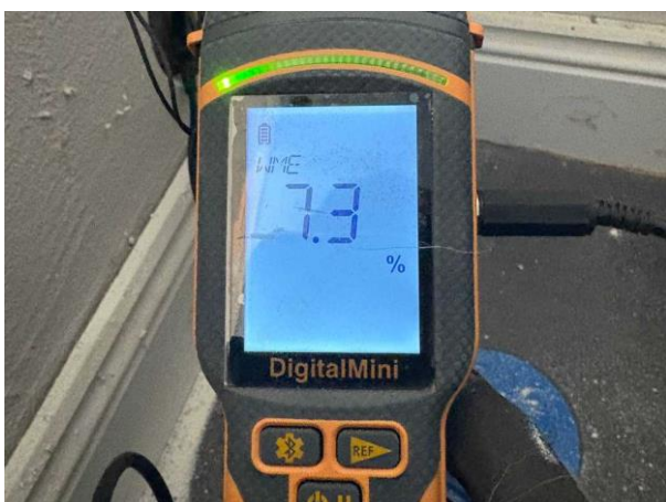
Bild 5: - Invändigt, Betongplatta på mark/inklädda källarväggar, Betongplattan är av äldre standard, se riskanalysen Det förekommer inklädda källarväggar med kons...
