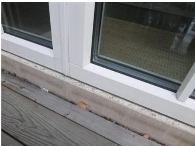
Bilden visar exempel på dörr där tröskelplåt inte finns.
