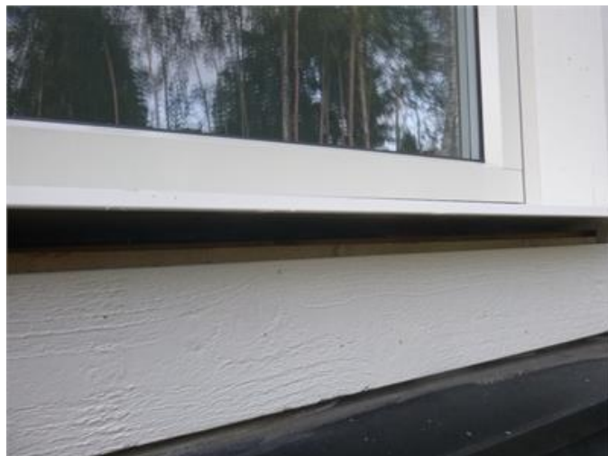
Bilden visar exempel på lös fönsterplåt (takkupan).
