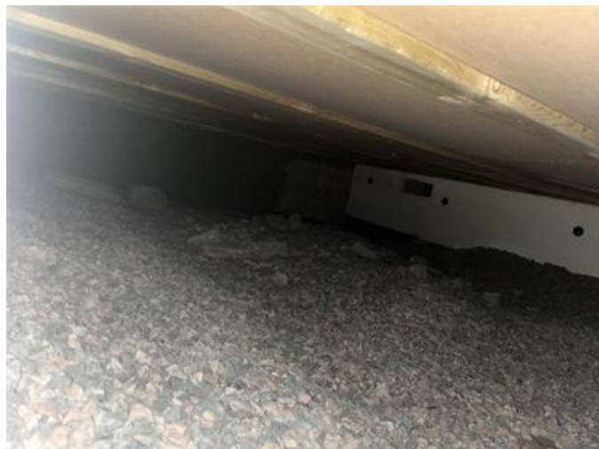
Bild tagen från krypgrund.
