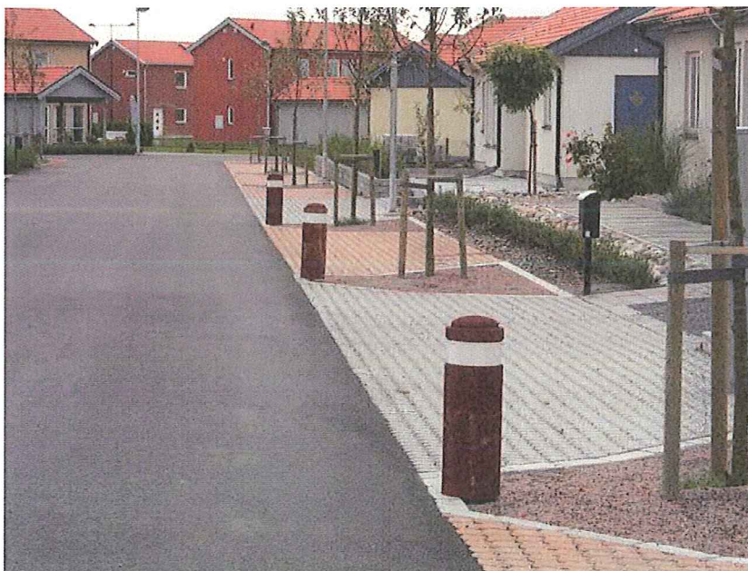
bild 5, betongsten med grusfogar vid utfarter. Sten satt som svackdike
