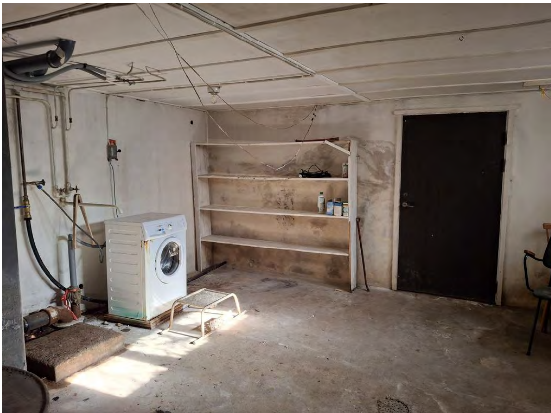
Tvättstuga med dörr till garage
