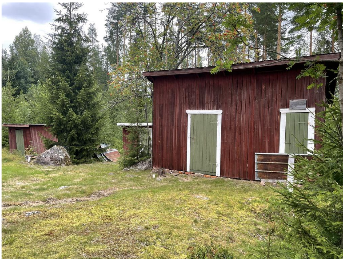
Vedskjul o dass närmast i bild
