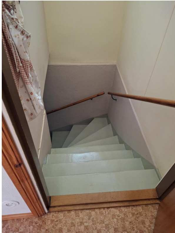
Trappan ner till källarplanet
