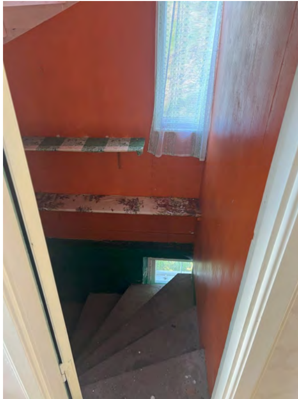
Trappan ner till källaren
