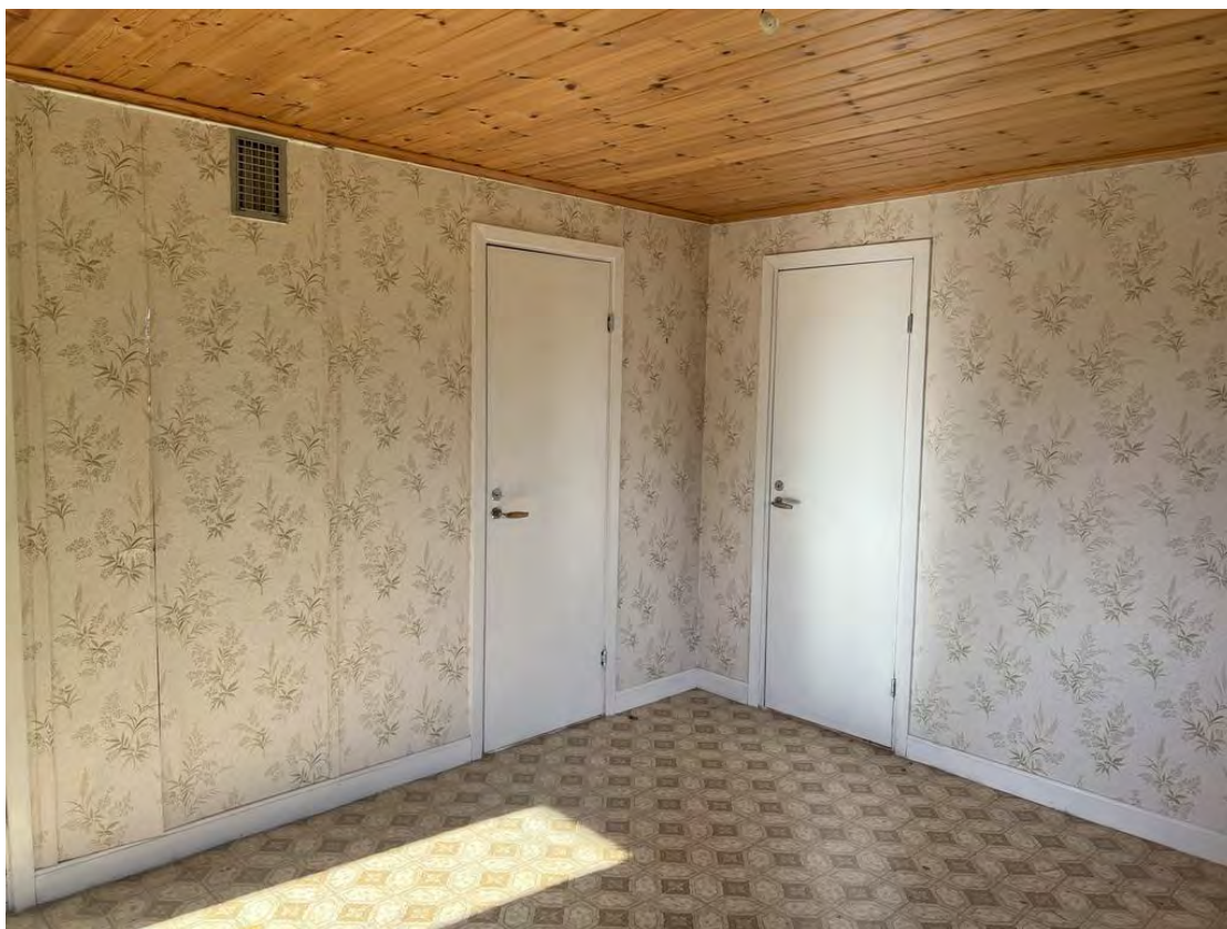
Sovrum 2 med dörr till isolerad kallvind samt till garderob.
