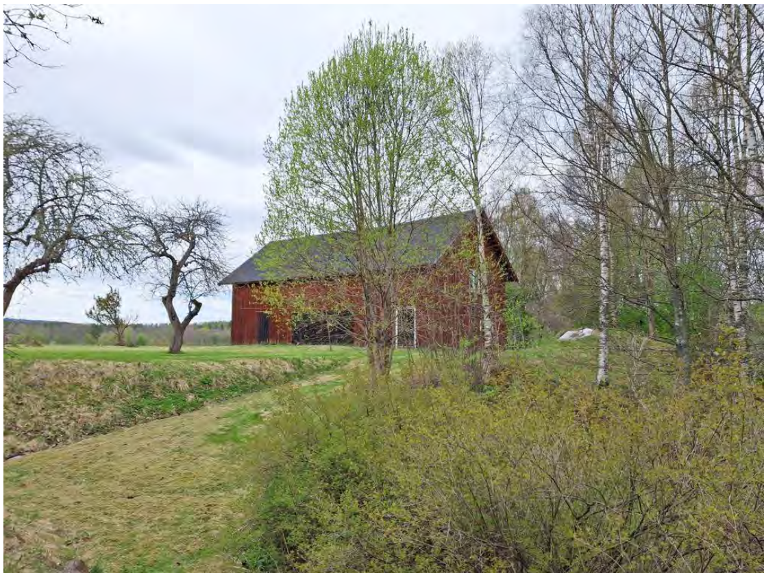
Ekonomibyggnaden med sommarlägenhet i högra delen
