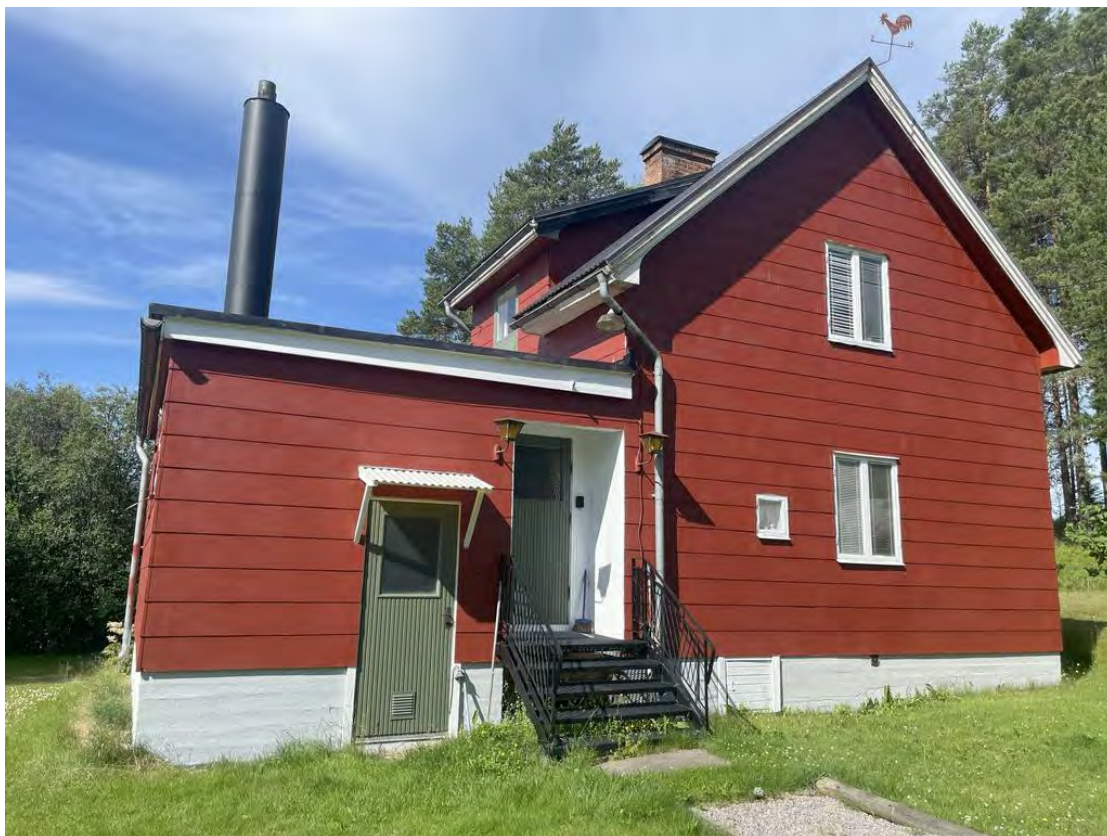
Entrén, pannrummet till vänster
