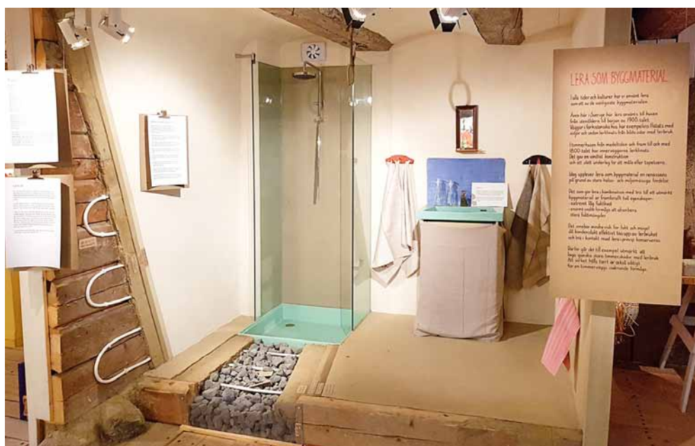
Okonventionellt och smakfullt badrum från utställningen på Nynäs slott från 2016, signerad Kjell Taawo, Johannes Riesterer m.fl. Äggoljetemperamålad lerputs med väggvärme på timmerväggarna. Äggoljetemperamålat linoljat lergolv med golvvärme. Glaskivor i lerbruk på ett grönt porslinsduschar utgör duschhörna. Blå tadelakt som stänkskyddsyta ovanför tvättstället. Den öppna gången fram till duschen visar golvet olika lager.
