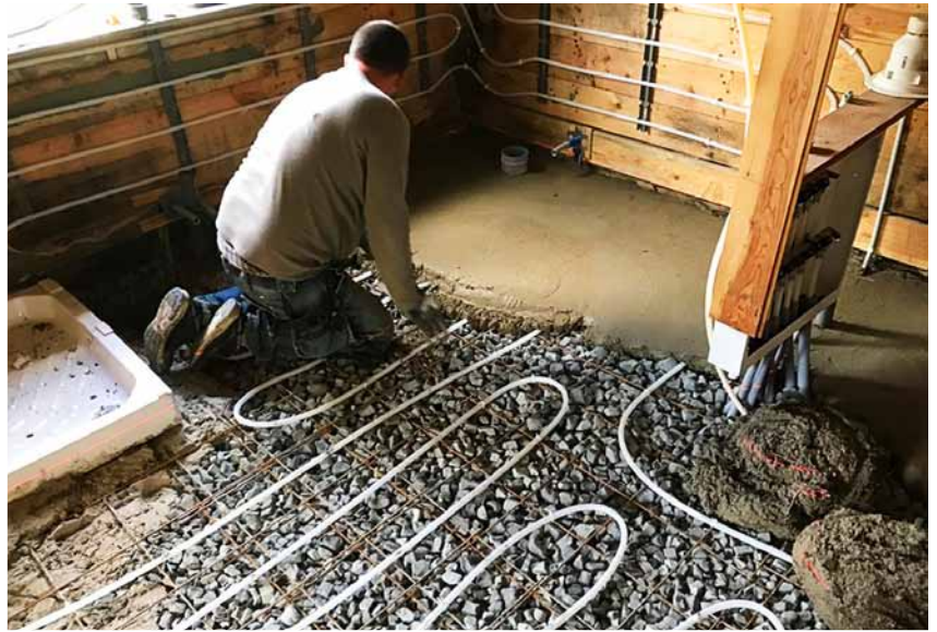
OVAN. Läggnig av lergolv med vattenburen golvvärme. Nedfällt kar för duschabin syns i vänsterkanten. Foto: Johannes Riesterer.
