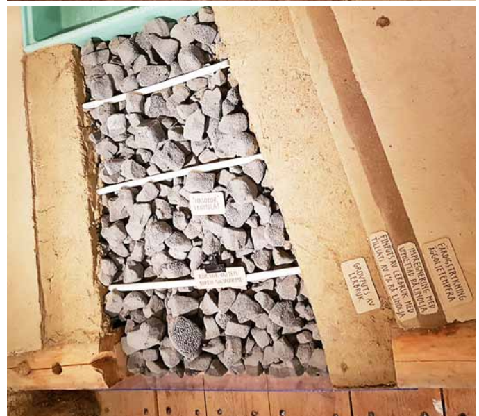
Schematiska bilder över de olika lagren i ett lergolv respektive vägg i ett våtrumme. Från utställningsrum, se nästa sida. Foto: Kjell Taavo.
