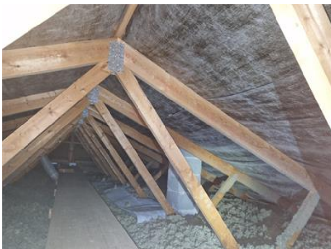
Nockvind, duk/väv som underlagstak.
