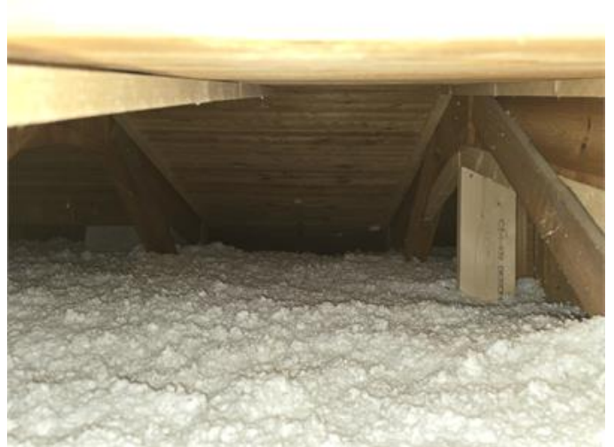
Nockvind: Översiktsbild från lucka i sims genom luftspalt.
