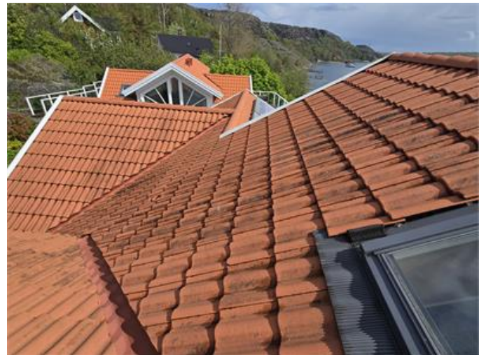
Tak: Översiktsbild mot öst.
