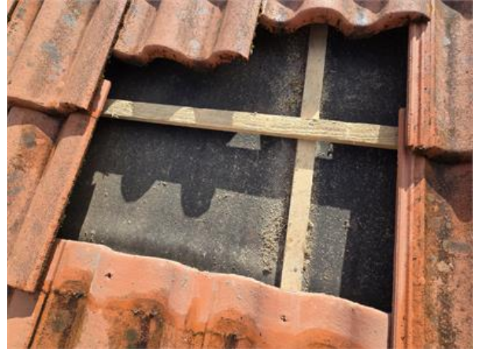
Tak: Stickprovskontroll under pannor.
